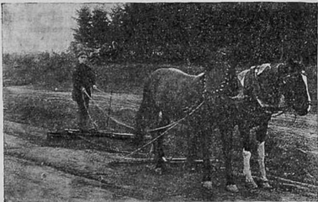
„Утюг“ придает грунтовой дороге нужный профиль
